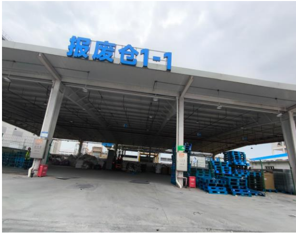
一般固废暂存间 (面积 1185m 2 )
