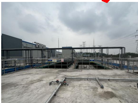
生产废水处理系统
