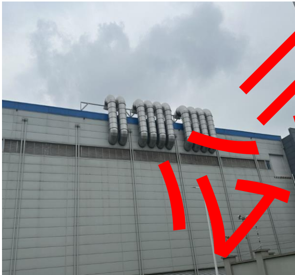
电芯厂房 1 阳极涂布、烘干有机废气的 10 根排气筒 (DA003~DA012, 直排)
