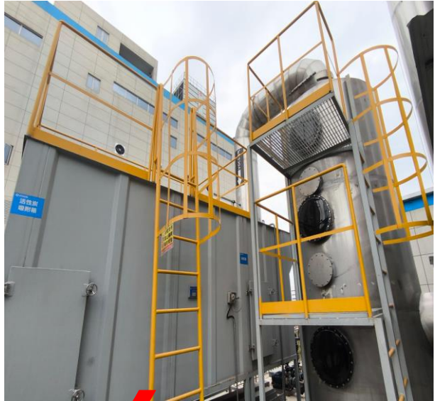
拆电池房及危废暂存间废气处理设施（碱洗+活性炭）
