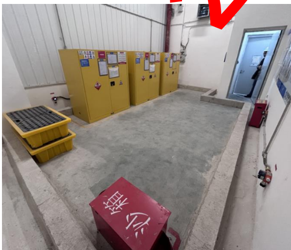
原料仓化学品间围堰、消防砂
