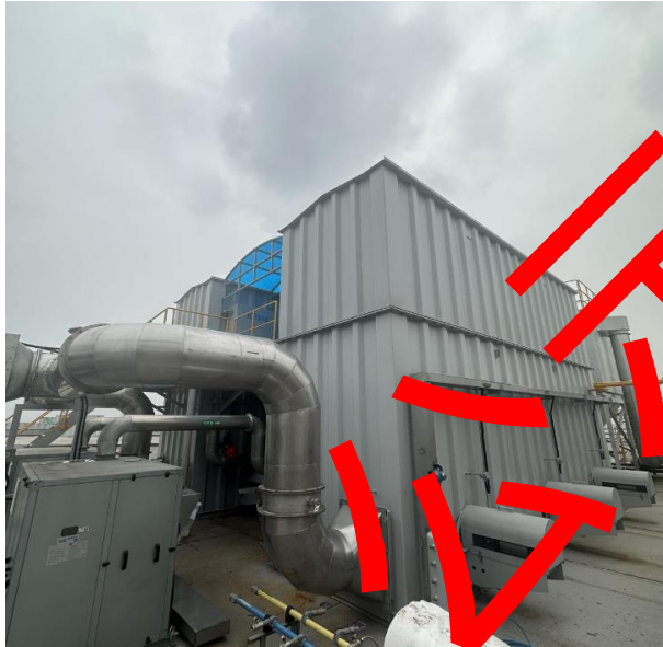
后处理工序废气 RTO 处理设施
