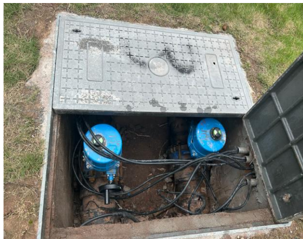
NMP 中转罐围堰及截流沟、收集井以及切换阀
