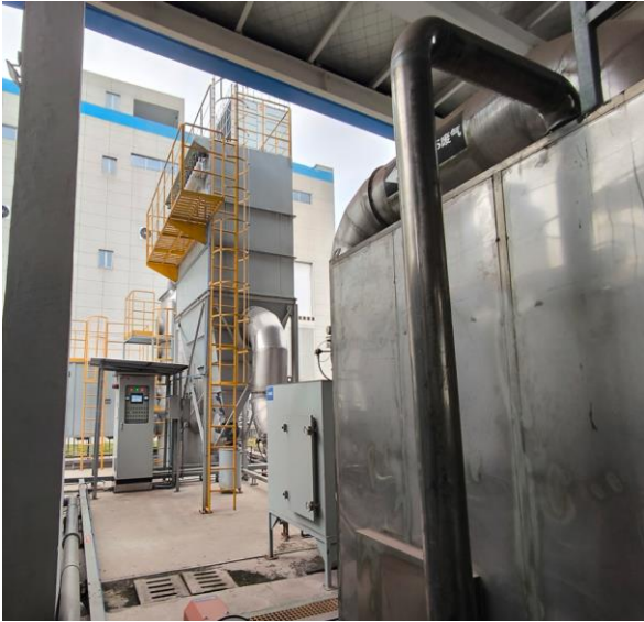
负极材料焚烧烟气处理设施（布袋除尘+碱洗+除雾+活性炭吸附）
