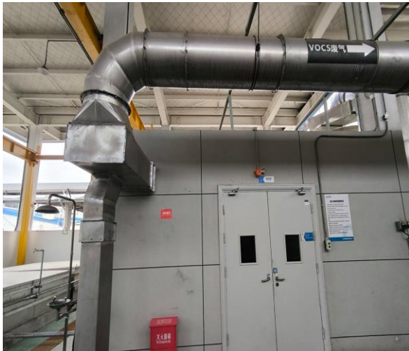
后处理工序废气 RTO 处理设施
