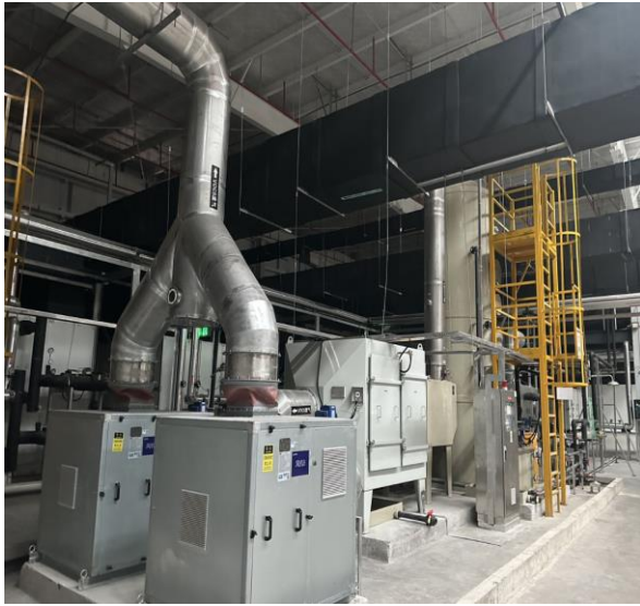
电芯厂房 1 阴极搅拌真空泵废气处理设施(冷凝+碱洗+活性炭吸附)及其排气筒(DA001)
