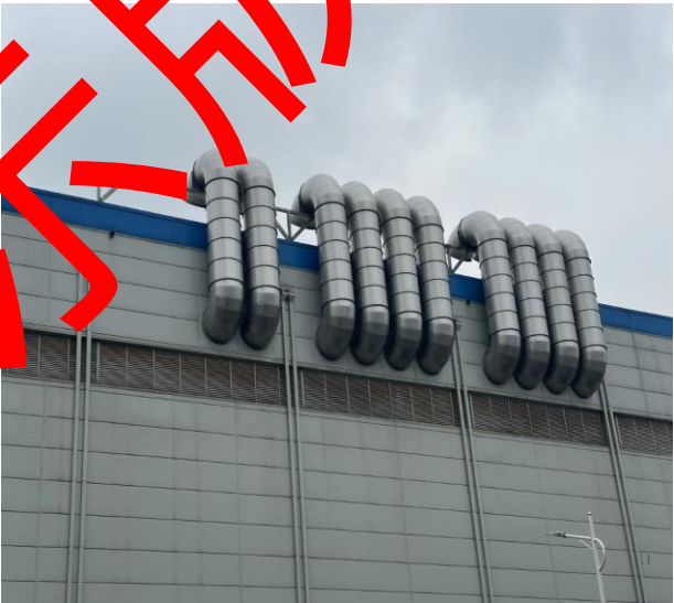
电芯厂房 1 阳极涂布、烘干有机废气的 10 根排气筒 (DA003~DA012, 直排)
