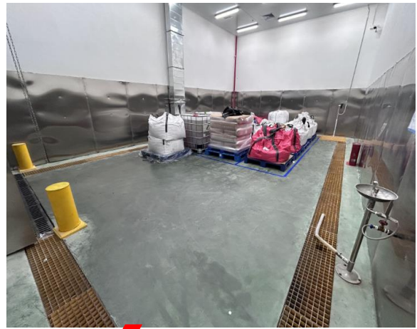
电芯厂房1废NMP暂存间 (53m 2 )
