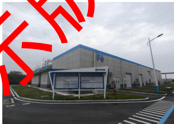
全厂污水处理站全貌
