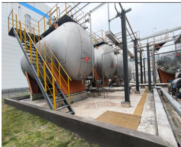
NMP 中转罐围堰及截流沟、收集井以及切换阀
