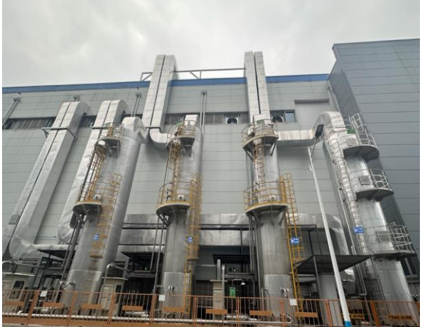
电芯厂房 1 阳极涂布、烘干有机废气的 10 根排气筒 (DA003~DA012, 直排)
