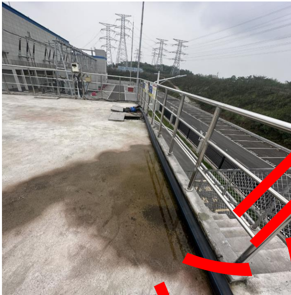
污水处理站清水池
