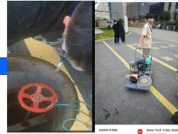
现场厂务应急人员携带应急装备进行污染区域管网抽排工作并关闭受影响区域应急阀门
