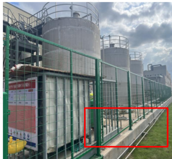
NMP 储罐区围堰
