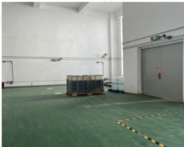
危险废物贮存间地面防渗地坪漆
