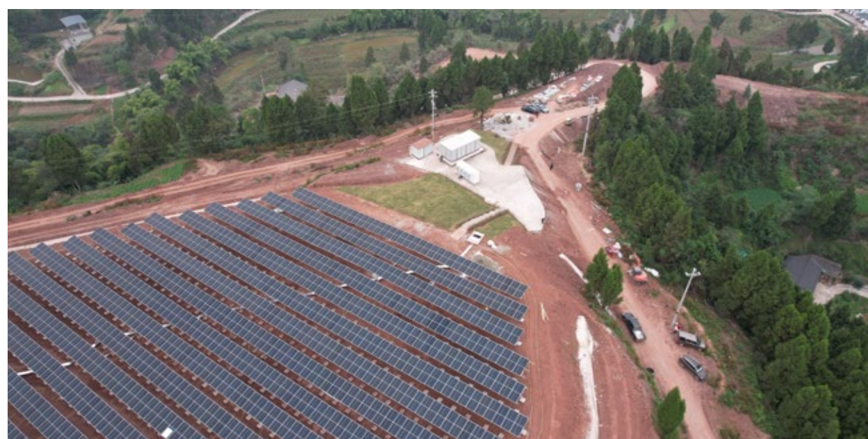
用户侧储能 重庆铜梁美丽乡村光储项目
