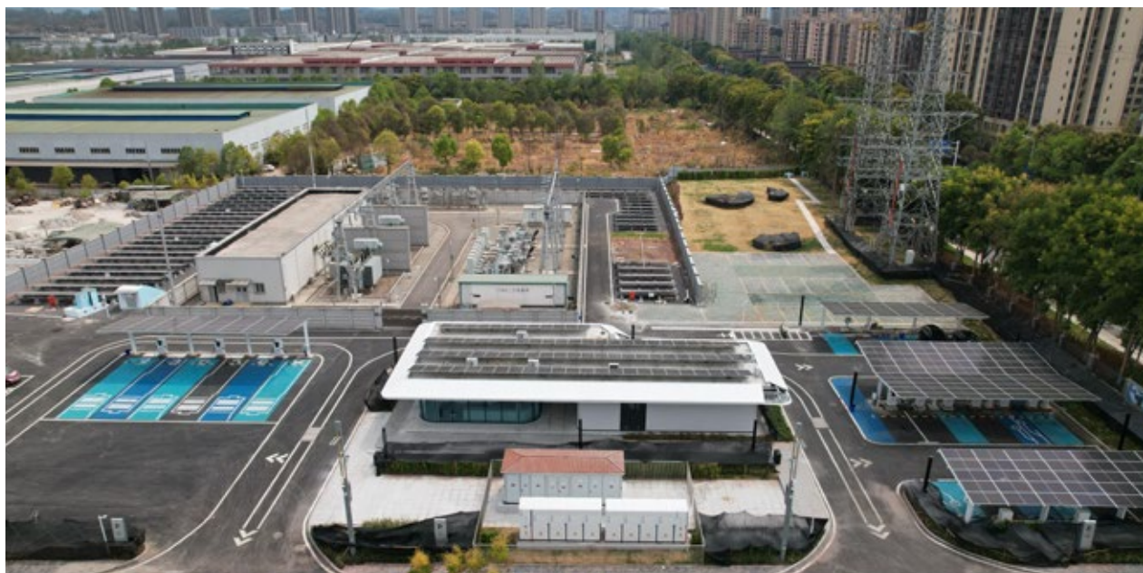
用户侧储能 重庆光储充检换一体站
